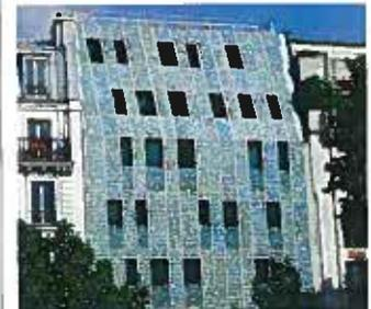
photovoltaïques et 16 panneaux solaires en toiture assurant 40 % de l'eau chaude sanitaire. Un projet de l'architecte Emmanuel Saadi.
